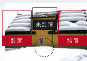
スーパーリング 設置後
