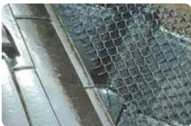
2 棟に合わせて本体と5mm鋼線をカットします。
