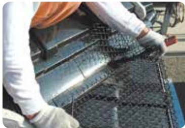
2 棟に合わせて本体と5mm鋼線をカットします。
