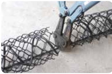
1 寸法に合わせてスーパーリングをカットし長さを調整します。
