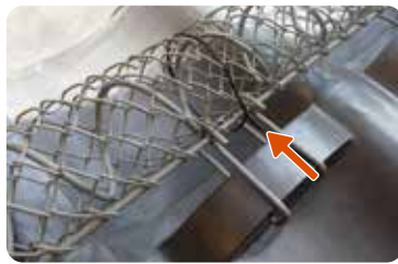
5 製品取付け後、取付部品との結合部に緩みがある等スーパーリングが外れる恐れがある場合には、1mに1箇所程度の間隔で取付部品とスーパーリングを結束し補強をしてください。(写真:A-1を用いた場合の例)
