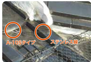
7 端部に一番近い瓦に、A-10Sタイプを取付け、フックと本体をステンレス線で結束します。
