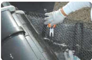
3 カットした部分を、ペンチで元のように曲げ戻します。
