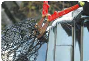
6 「ゆきもちくん(S)」の場合、コイル、5mm鋼線もカットします。 ※「ゆきもちくんデルタ」「スーパーデルタ」の場合は定尺でのご利用を推奨します。
