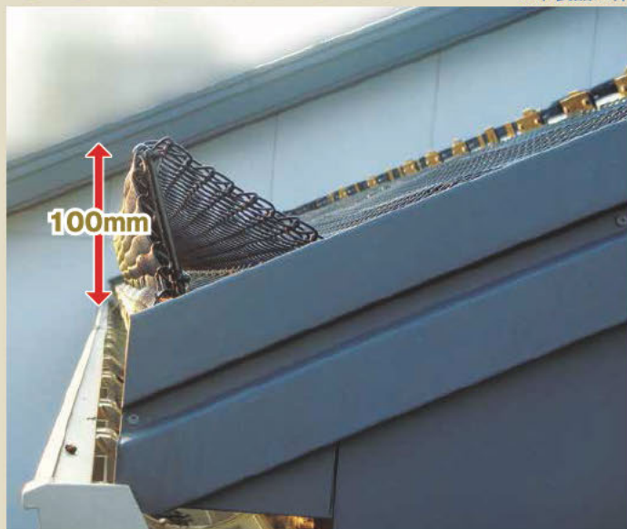
(平板瓦用)標準施工図
