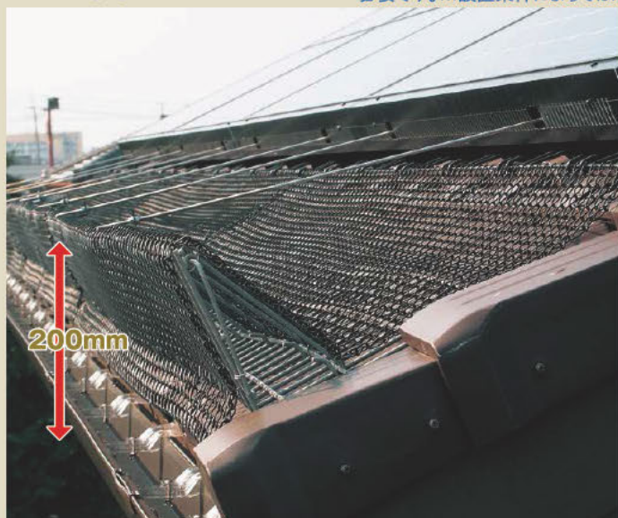
(平板瓦用)標準施工図
