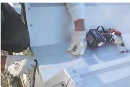
**1** 折板屋根の凹部に6.5mmの穴を開けます。
