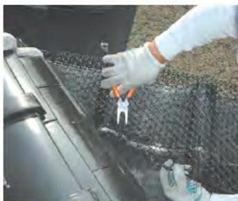
**3** カットした部分を、ペンチで元のように曲げ戻します。
