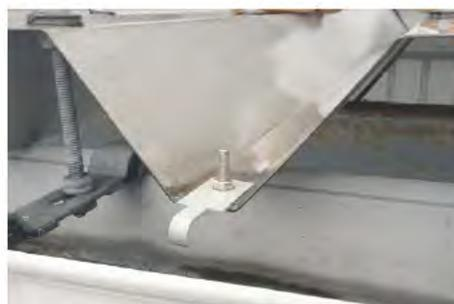
**2** A-20をフックが下向きになるように折板屋根の上に置き、下からボルトで固定します。
