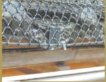
**3** 上部取付部品と同様に下部取付部品のフックに5mm鋼線を引掛けます（部品取付方法はP.10を参照）。
