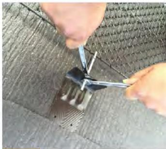
**2** その穴にA-9を通し長さを調整後、雪止め金具立ち上がり部分の両側からナット(M6)で固定します。
