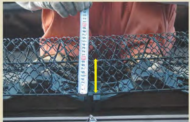
「ゆきもちくんS」「ゆきもちくんデルタ」「スーパーデルタ」「ビッグエル280」の製品全体寸法の測り方は「ゆきもちくん」（上記2）と同じですが、屋根材天端から下部取付部品までの寸法（黄色矢印部分）を別途測定する必要があります。この寸法は取付部品、屋根材及び屋根形状によって異なりますので、ご注文の際には該当寸法を必ずご指示ください。
