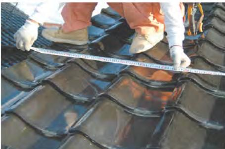
**1** 端尺がある場合、端尺部分の寸法を測ります。
