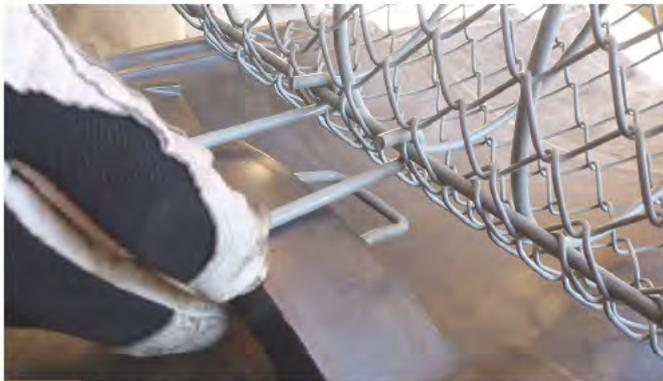
**3** 上部取付部品を雪止め瓦及び雪止め金具に取付け、スーパーリングに通してある5mm鋼線に引掛けます。
