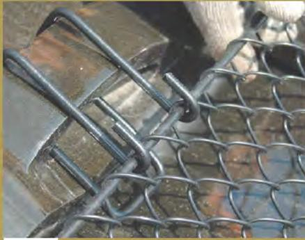
**1** 上部取付部品（部品取付方法はP.8を参照）のフックに準備工で製品本体の上下端に予め通しておいた5mm鋼線を引掛けます。
