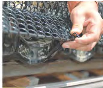
**3** テコの原理を利用し押し込みながら軒先に取付けます。
