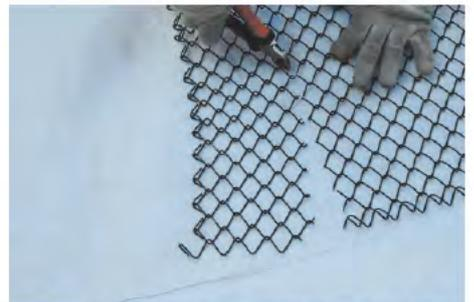
**3** 確認した位置を、クリッパーで縦にカットしていきます。5mm鋼線も同じ寸法にカットします。
