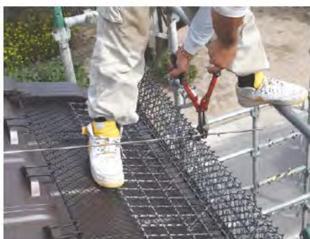
**3** サポートバーの本体から突出した部分をクリッパーで切断し長さを調整します。
