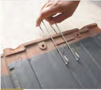
**1** 設置したい瓦の奥の部分にフックが上向きになるように部品をはめ込みます。
