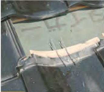
**1** 設置したい瓦の一枚上の瓦をはずし、設置したい瓦の奥の部分にフックが上向きになるように部品をはめ込みます。
