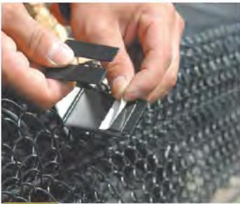
**1** 内側に貼ってある両面テープを剥がします。※両面テープは取付けを容易にするための仮止めです。
