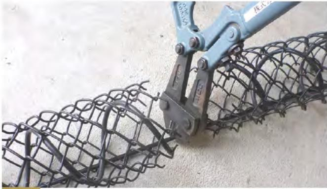
**1** 寸法に合わせてスーパーリングをカットし長さを調整します。
