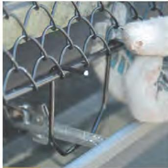
**2** 雨樋受け金具の中央に部品を通し5mm鋼線を引掛けます。
