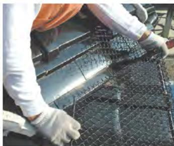
**2** 棟に合わせて本体と5mm鋼線をカットします。
