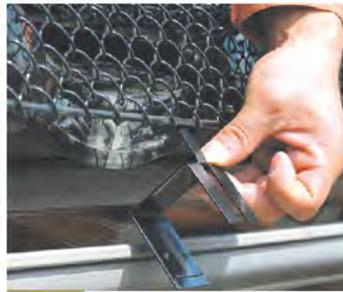
**2** フックが下向きになるように5mm鋼線に引掛けます。
