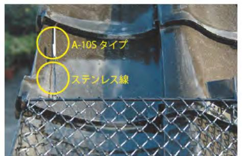
**6** 端部の瓦に上部部品を取付ける場所が無い場合は、A-10Sタイプを取付け、フックと本体をステンレス線で結束します。
