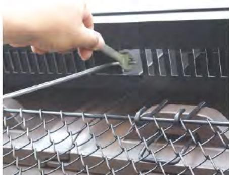
**1** 太陽光パネルの架台等に6.5mmの穴をあけ、サポートバーの曲り部分を通しナット(M6)で緊結します。
