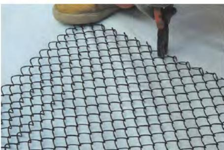
**4** カットした部分を、ペンチで元のように曲げ戻します。
