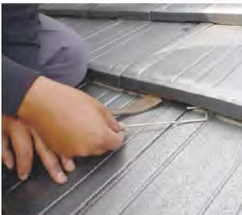
**1** A-10Sを横に倒し、設置したい瓦とその一枚上の瓦との間に滑り込ませます。
