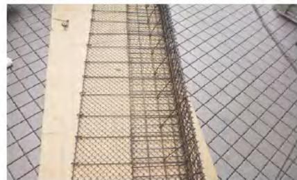
**1** 製品本体の底部に骨材を差し込みます。同梱されている骨線を製品底部の長さに合わせて切断し、製品本体の上端(屋根上手側)からネット断面の中心を縫うように差し込みます。最後は上端に通してある5mm鋼線にフックを引掛けて固定してください。骨線は必ず約130mm間隔で差し込むようにしてください。
